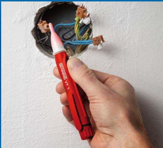
Phasenprüfung an Abzweigdose mit BENNING VT 1
